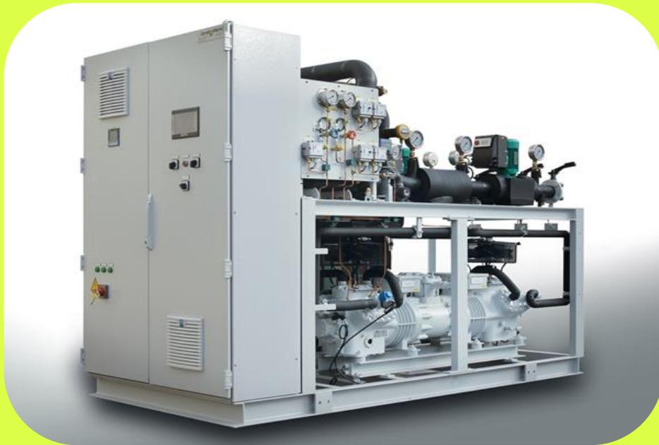
Eine **Wasser-Wasser-Wärmepumpe** ist eine Art von Wärmepumpe, die Wärme zwischen zwei Wasserströmen (einer Quelle und einer Senke) überträgt. Sie ist in der Lage, die im Wasser vorhandene Wärmeenergie zu nutzen, um sowohl zu heizen als auch zu kühlen.
