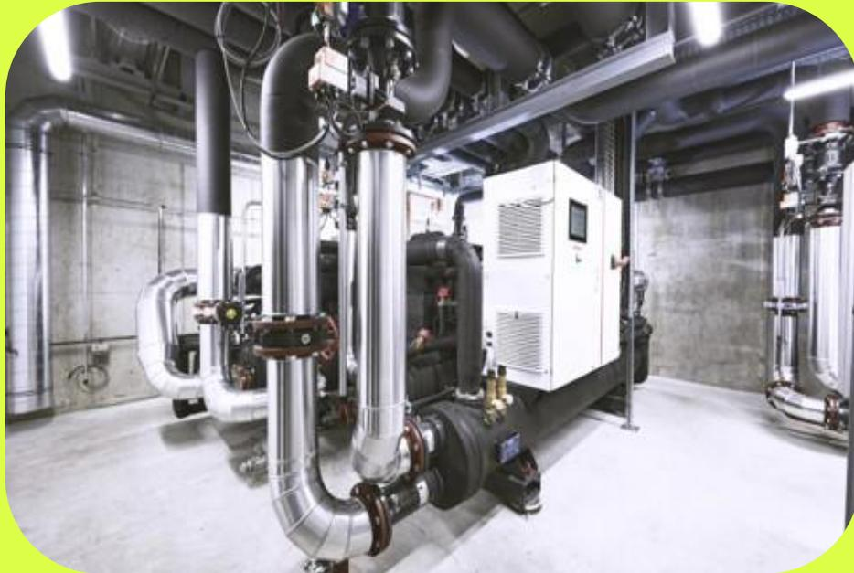
Eine **Wärmepumpe** nimmt thermische Energie aus einer Quelle mit niedrigeren Temperaturen auf und wertet sie zusammen mit der eingesetzten Betriebsenergie (meistens elektrischer Strom) auf eine höhere Temperatur auf. Wärmepumpen werden häufig zur Temperaturaufwertung von Abwärme aus (luftgekühlten) Rechenzentren eingesetzt.
